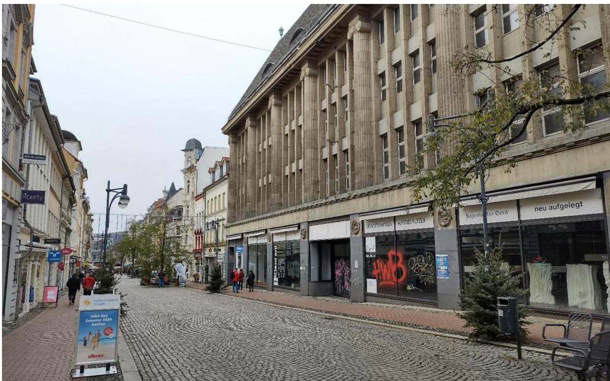
Foto 3: Leerstand Tietz-Kaufhaus in Gera
