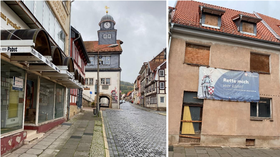
Foto 5: Leerstand im Ortskern von Bleicherode
